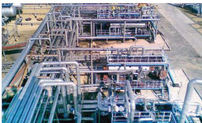
Установка подготовки газа и стабилизации конденсата, Q_{\text{газа}}=4\ 000\ 000\ \text{нм}^3/\text{сут} , Q_{\text{конд.}} = 700\ \text{т}/\text{сут} . Технология: НТС с дроссель эффектом
