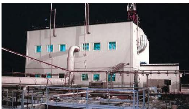
Полнокомплектная установка предварительной сепарации газа, Q_{\text{газа}}=780\ 000 - 10\ 400\ 000\ \text{нм}^3/\text{сут} .
