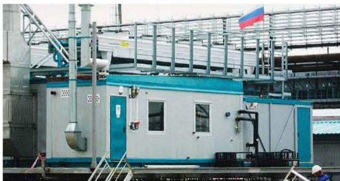
Блок подготовки топливного газа БПТГ, Q=46\ 800\ \text{нм}^3/\text{сут} . Технология: НТК с использованием холо- дильной машины.
